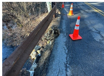
Spencer Brook Guardrail - 2.jpg
