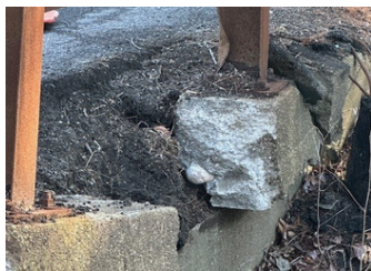
Spencer Brook Guardrail - 1.jpg
